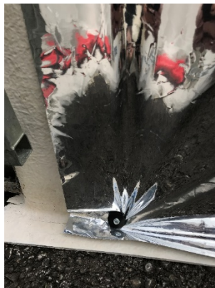
Abbildung 3: Befestigung der Folie am Iglu
